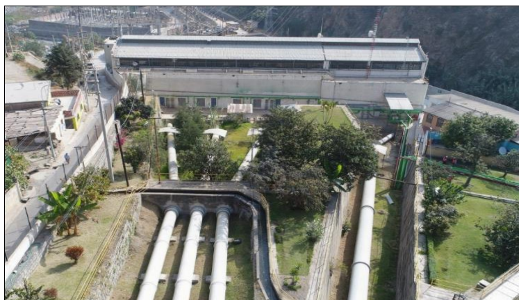
Central Hidroeléctrica Callahuanca.
