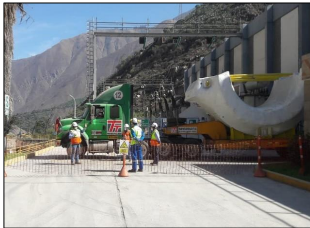
Reemplazo del estator en la Central Matucana.
