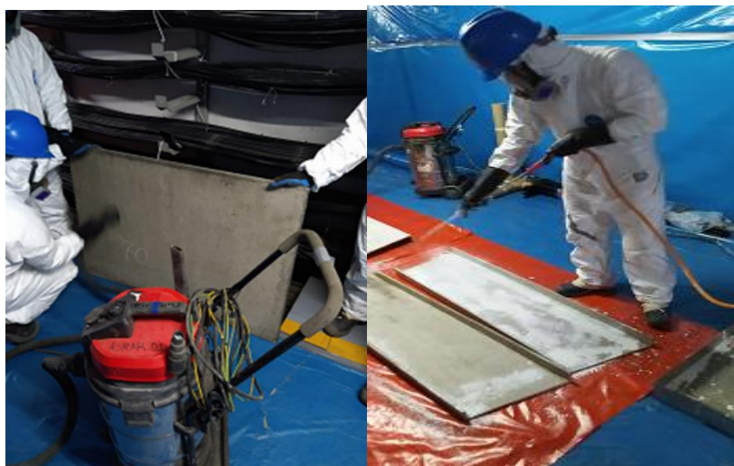
Retiro de bandejas con asbesto.
