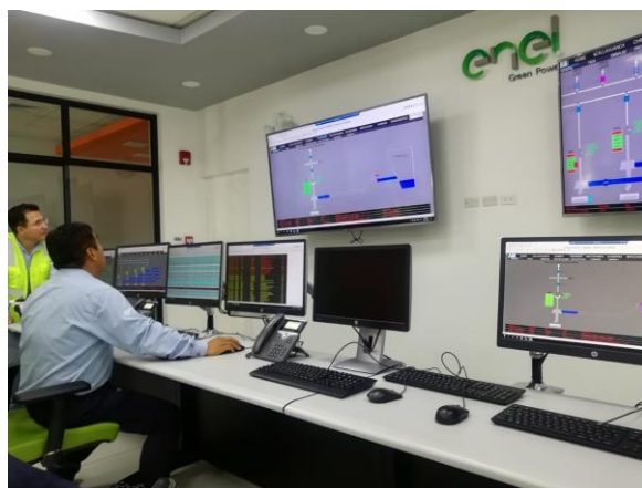
Nuevo centro de control ubicado en Moyopampa.
