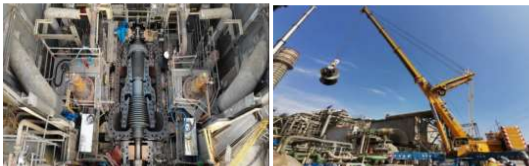
Mantenimiento Mayor Turbina de Vapor - C.T. Ventanilla.
