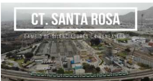
Cambio de silenciadores Chimenea TG8.
