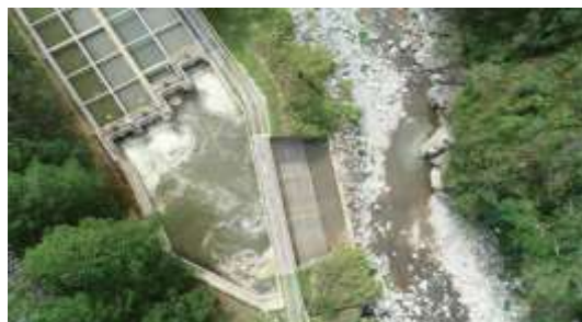
Inspecciones Toma Tarma.
