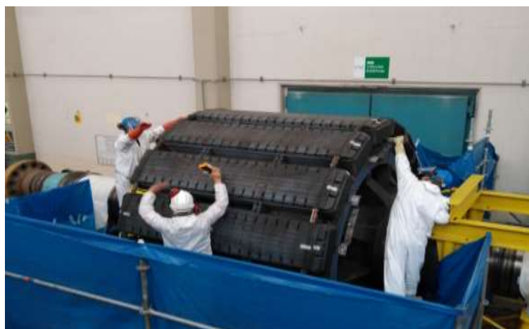
Cambio de estator del generador Unidad 1 de Matucana.
