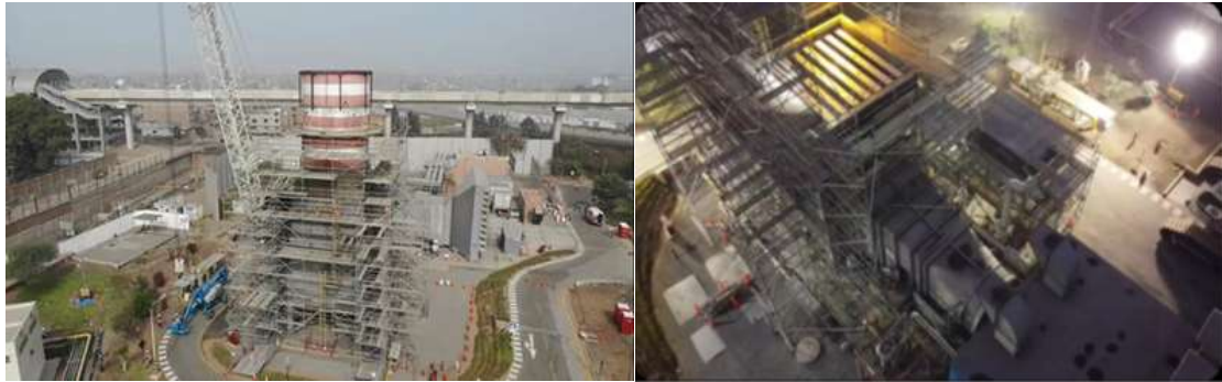
Foto: Rehabilitación de la chimenea Unidad TGB - Santa Rosa.
